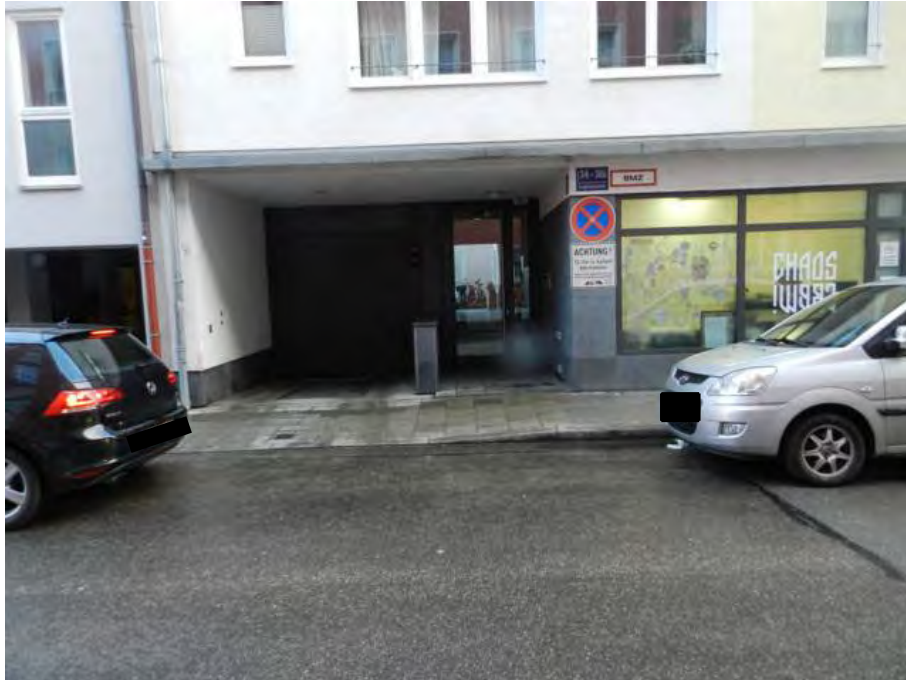
TG-Ein-/Ausfahrt bei Gebäude Erzgießereistraße 34
