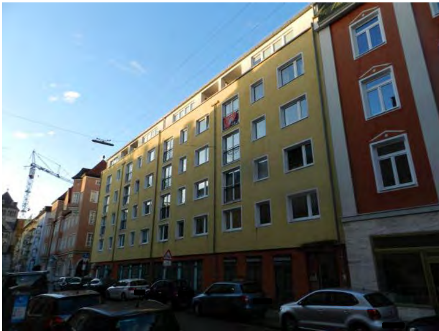
Ansicht von Süden von der Kreittmayrstraße
