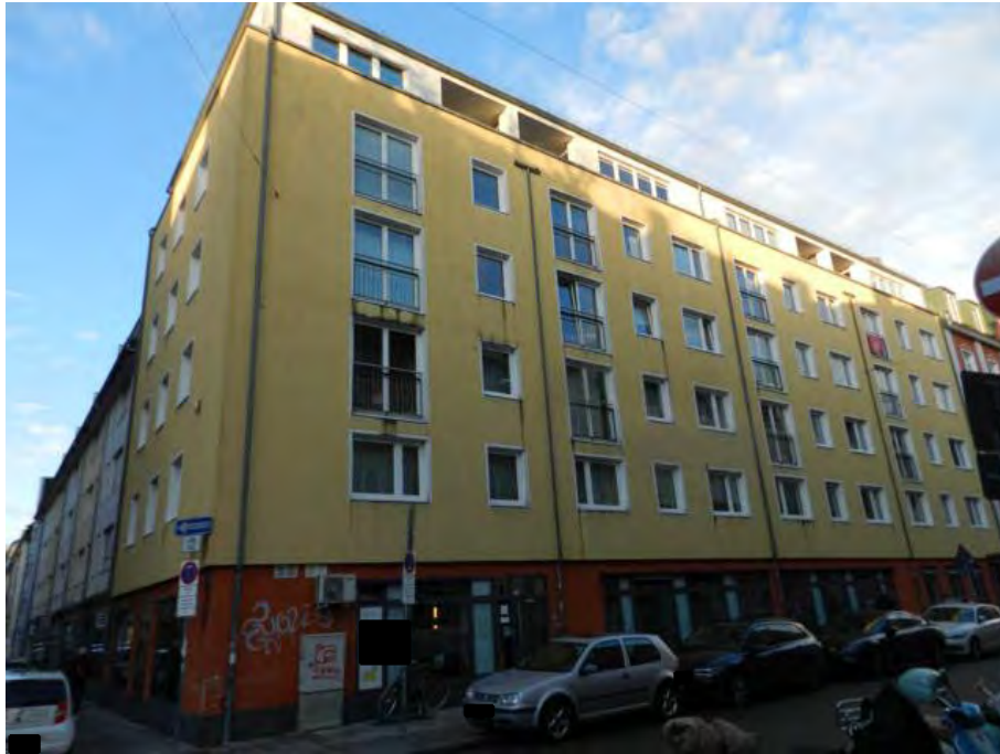
Ansicht von Süden von der Kreittmayrstraße
