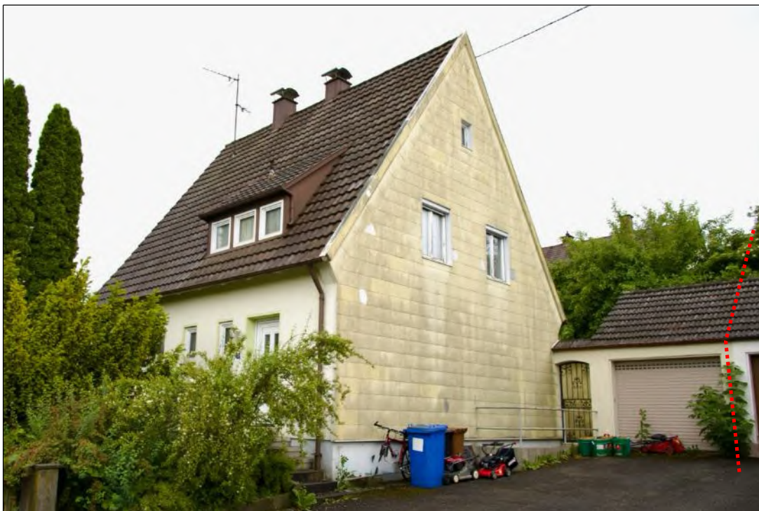
Foto 2 Ansicht von Westen
