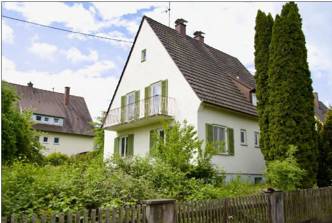
Foto 3 Ansicht von Osten
