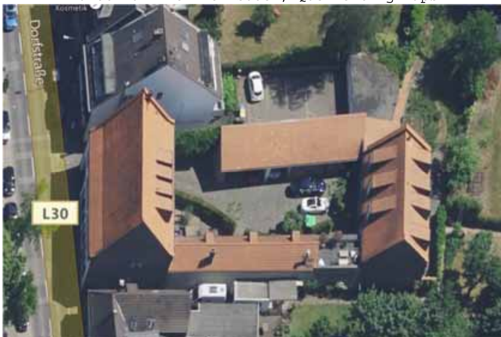
Luftbild Blick von Westen, Quelle bing maps
