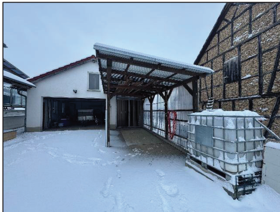
Hof-/Ostansicht - Nebengelass Garage mit vorgesetztem Carport und Garagentor
