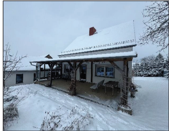
West-/Rückansicht - Einfamilienhaus mit überdachter Terrasse
