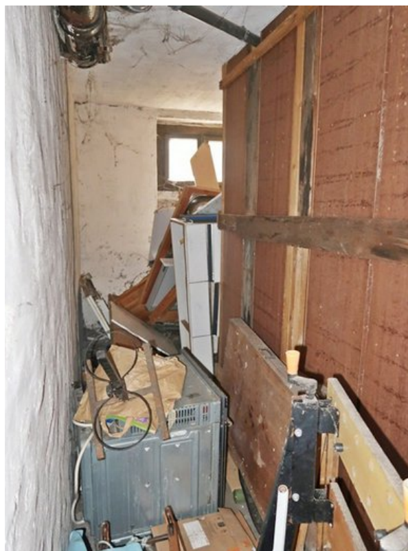
Kellerraum mit Sperrmüllablagerungen
