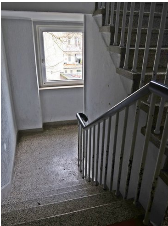
Treppenhaus mit Treppenlauf zum Untergeschoss
