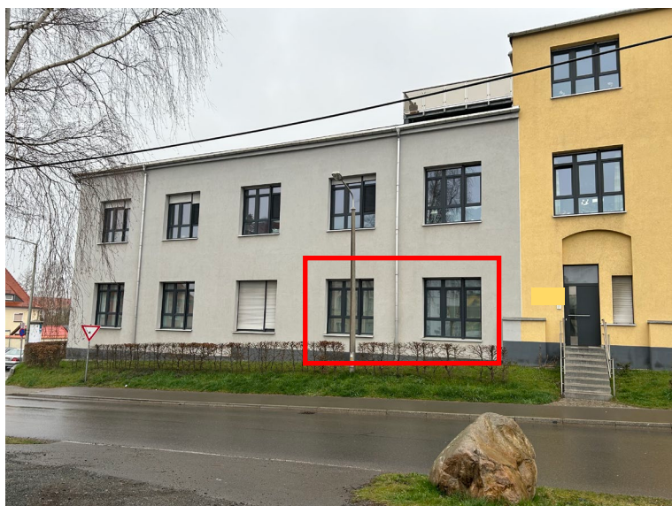
Abb. 03 Teilansicht des Wohn- und Geschäftshauses von der Straße Knappenweg aus und Lage der Büroeinheit BE 13 im Erdgeschoss
