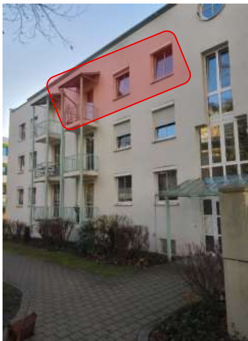
Ansicht von Nordwesten mit grober Kennzeichnung der zu bewertenden Wohnung
