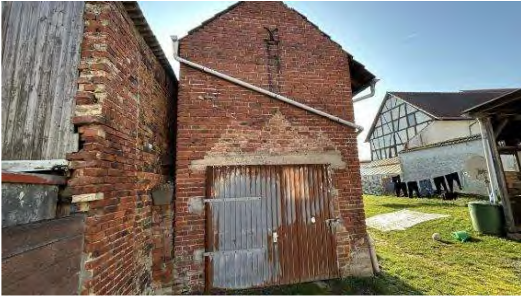
Bild B8 Nebengebäude
