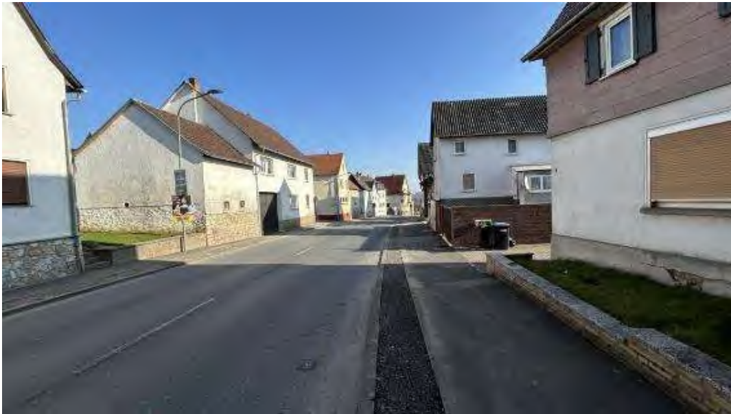
Bild A1 Blick in die Erschließungsstraße
