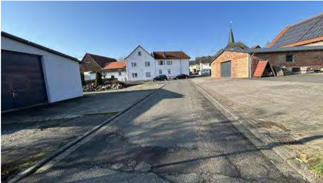
Bild A3 Blick in die Erschließungsstraße
