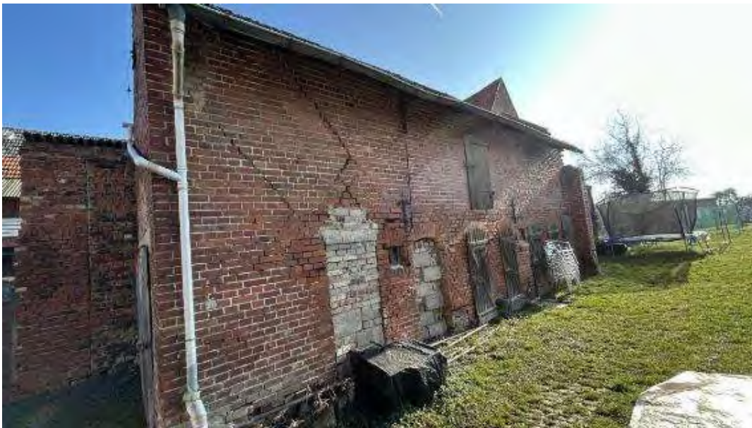
Bild B9 Nebengebäude
