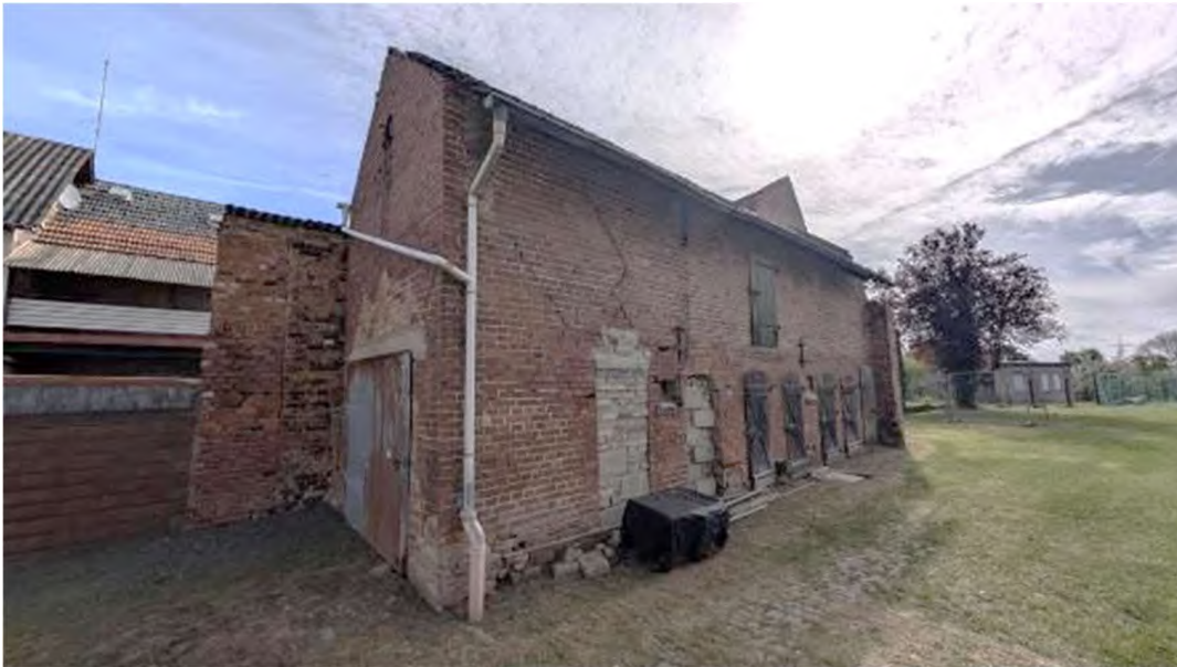
Bild B10 Nebengebäude
