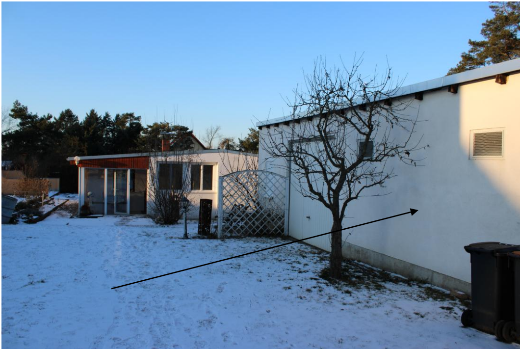
Foto Nr. 1: Ansicht Südseite
