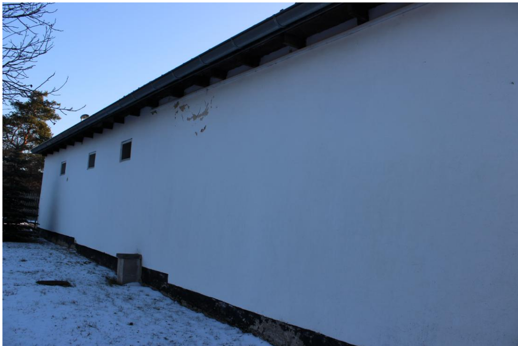
Foto Nr. 2: Ansicht Nordseite
