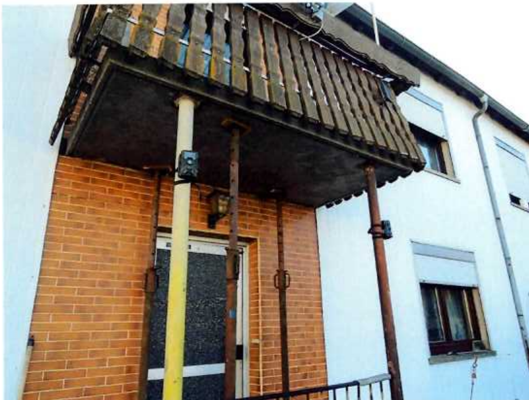
Balkon mit Metallstützen
