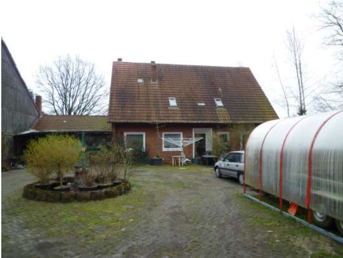
Frontansicht Wohnhaus / Gebäudeplan Nr. 1 / Ansicht aus westlicher Richtung
