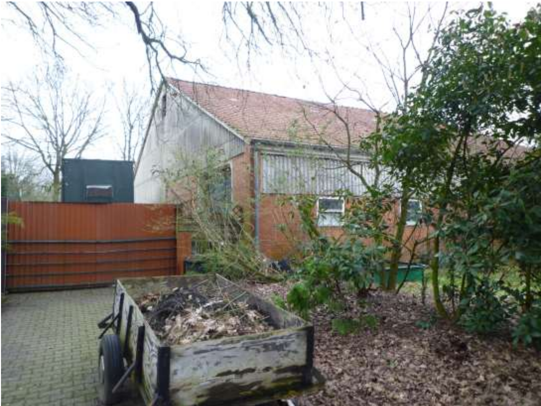
Rück- / Seitenansicht Wirtschaftsgebäude / Gebäudeplan Nr. 2 / Ansicht aus nordwestlicher Richtung
