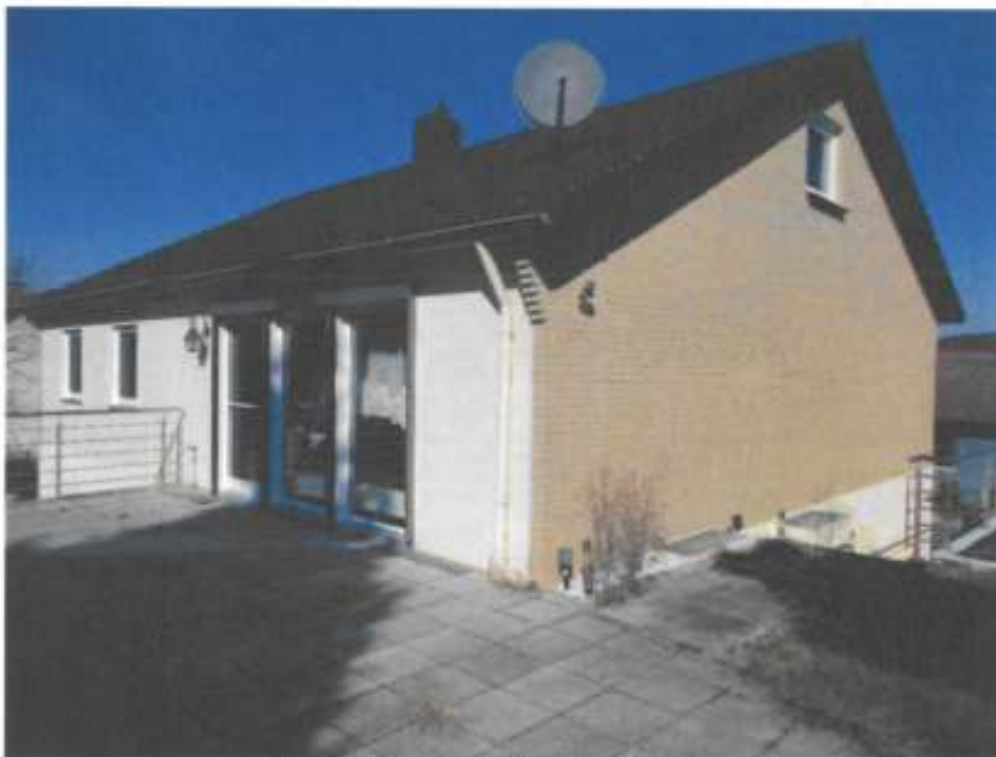
Rückwärtige Ansicht des Objektes
