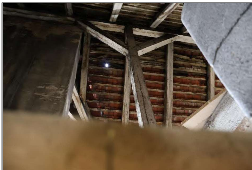
Dachboden (nicht ausgebaut)
