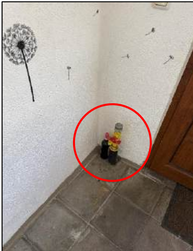
Neuer Gasanschluss im Flur
