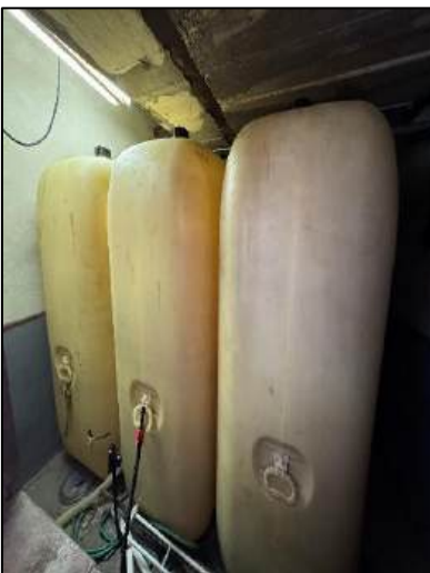
Innenansicht - Ehem. Öllager
