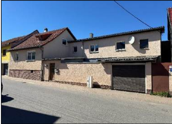
Straßenansicht - Einfamilienhaus & Anbau sowie Garage
