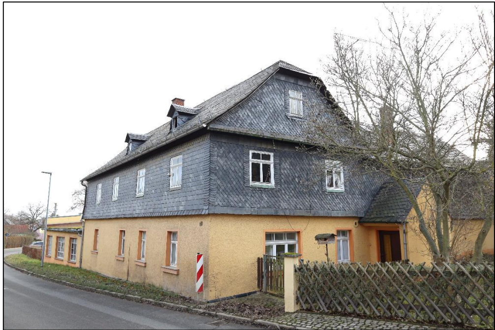
Nordwestansicht – Ländliches Wohnhaus
