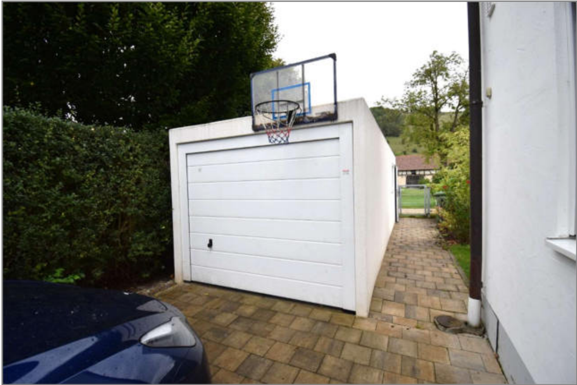
Blick nach Osten auf die Garage in der nordöstlichen Grundstücksecke
