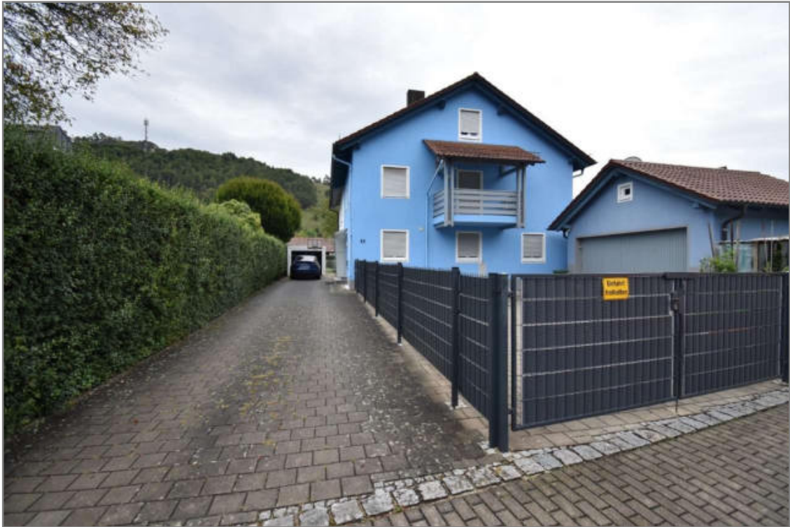
Blick von der Flurstraße aus nach Osten auf das Bewertungsgrundstück
