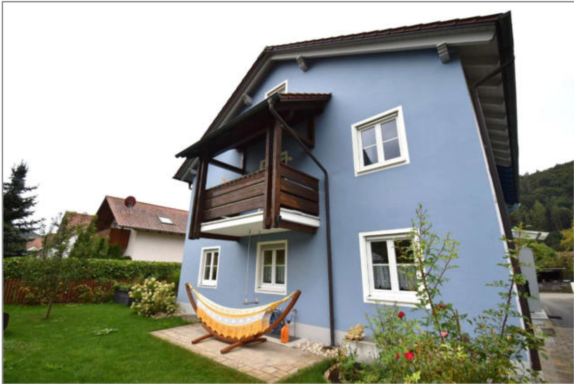
Blick nach Südwesten auf die östliche Giebelseite der Doppelhaushälfte samt Balkon a
