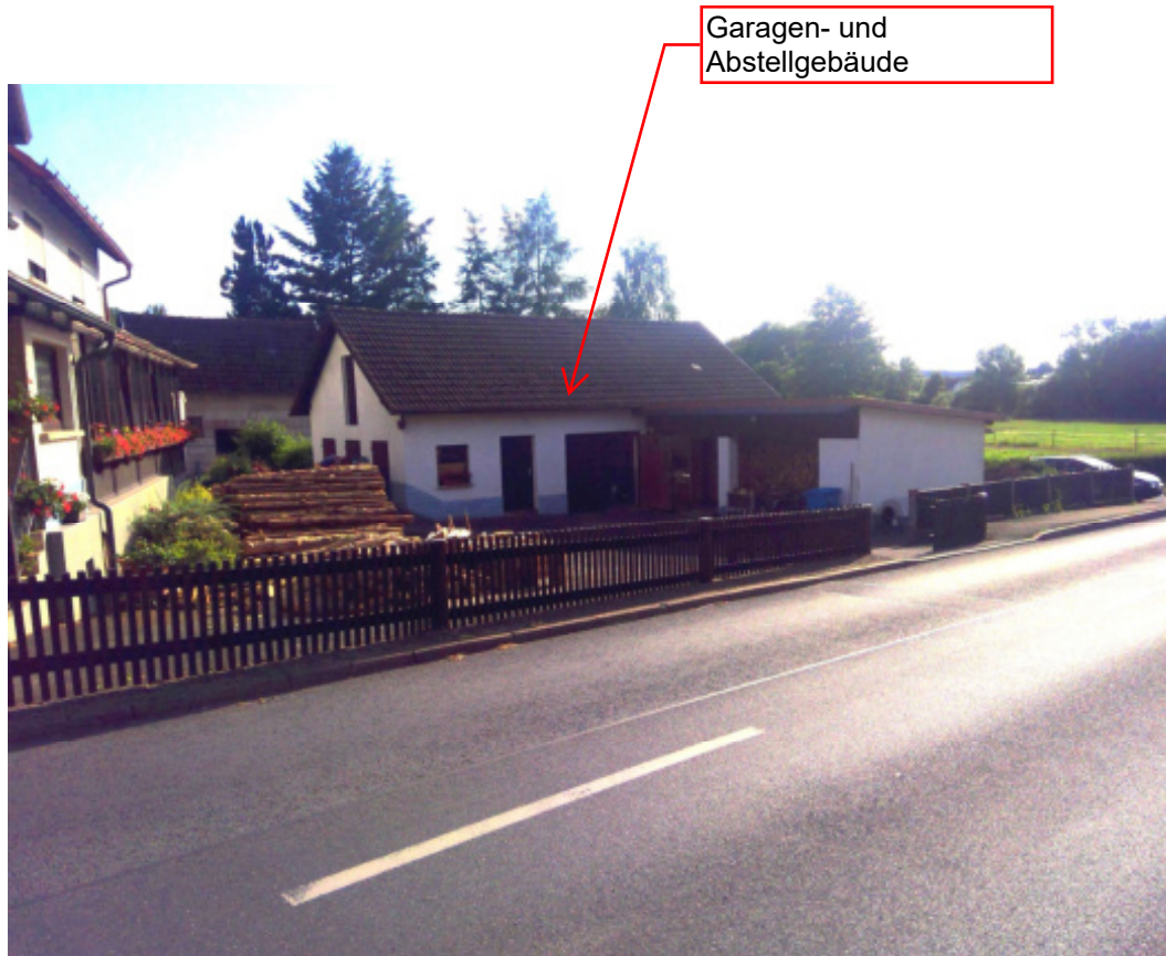
Blick von der Bundesstraße in südwestliche Richtung
