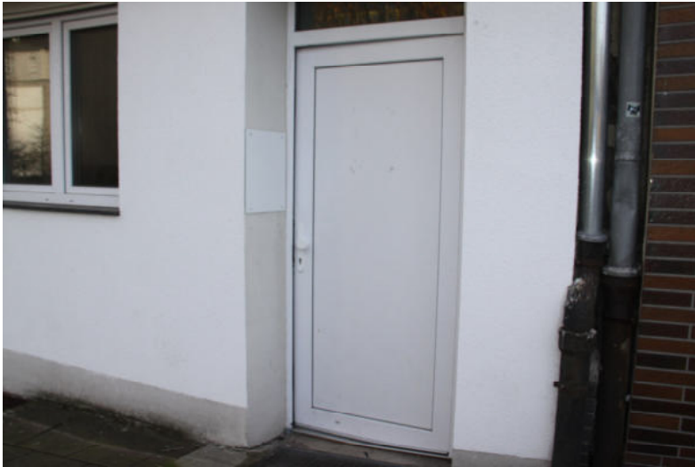
Bild 2 wie vor, Hauseingang
