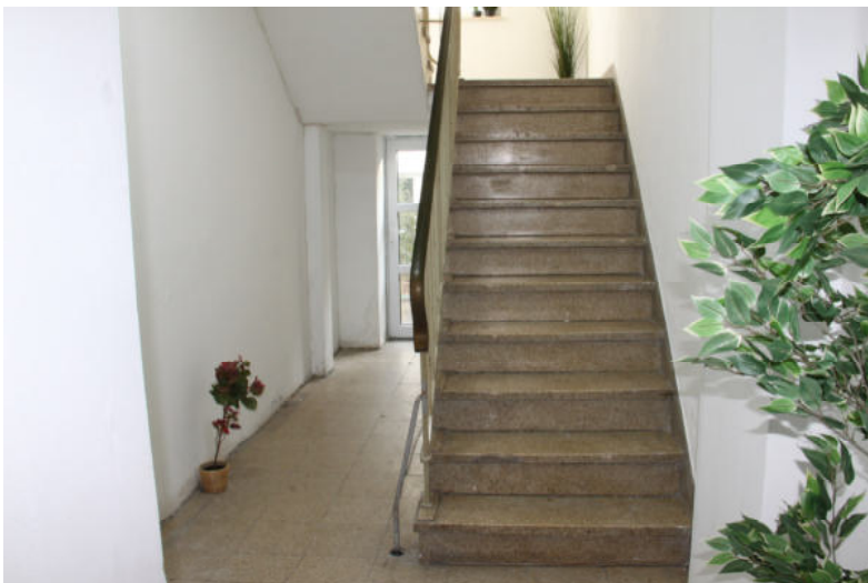
Bild 4 Treppenhaus, Stahlbetontreppe mit Kunststein, Metallgeländer mit Mipolam- Handlauf
