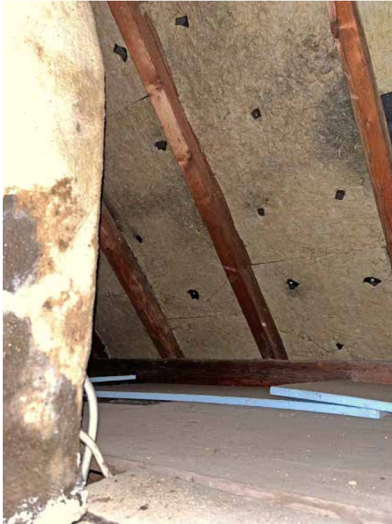
Spitzboden, teilweise gedämmt
