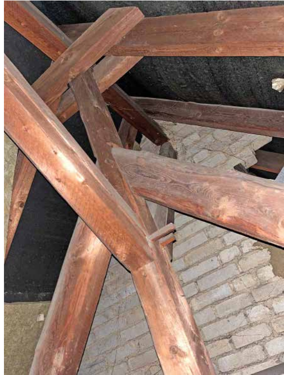
Dachstuhl im Spitzboden
