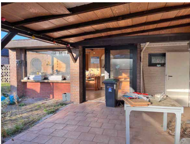
Terrassenüberdachung in Richtung Wintergarten mit Zugang zur Waschküche
