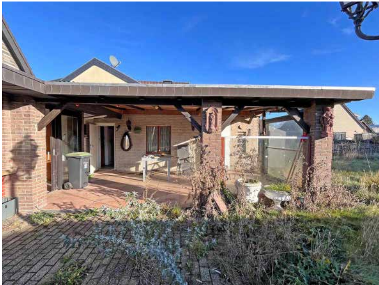
Terrassenüberdachung, Ansicht von Südwesten
