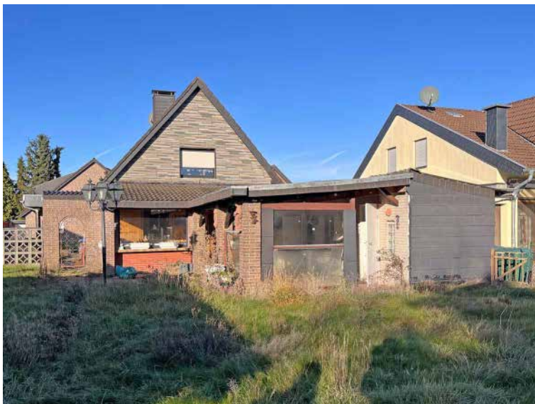
Ansicht von Südosten mit Anbauten und Terrassenüberdachung
