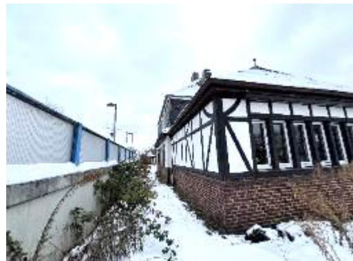
Blick entlang der nördlichen Lärmschutzwand (2)
