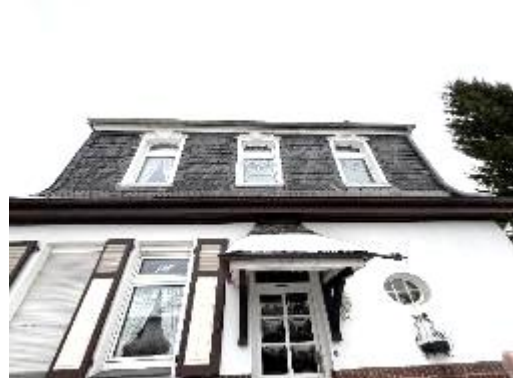
Ansicht Dachbereich über Eingang
