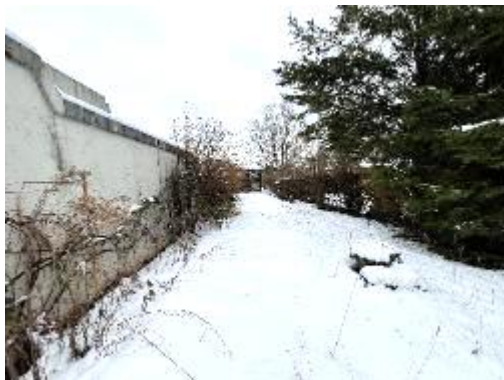
Blick entlang der nördlichen Lärmschutzwand (1)
