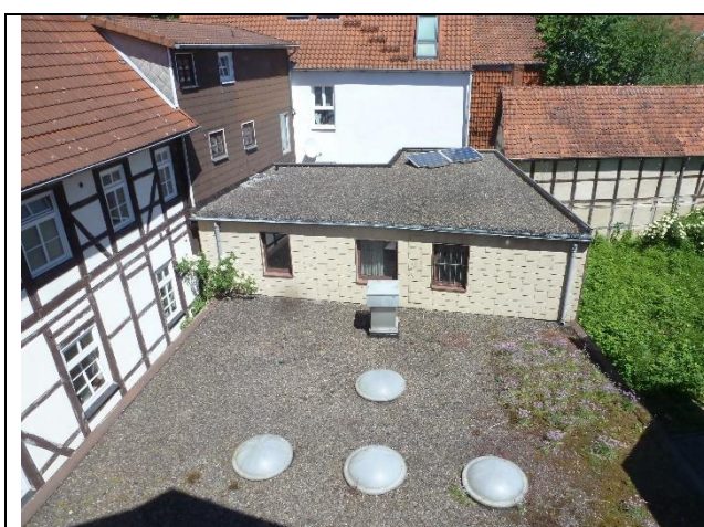
Ansicht von Süden (Hinterhaus)
