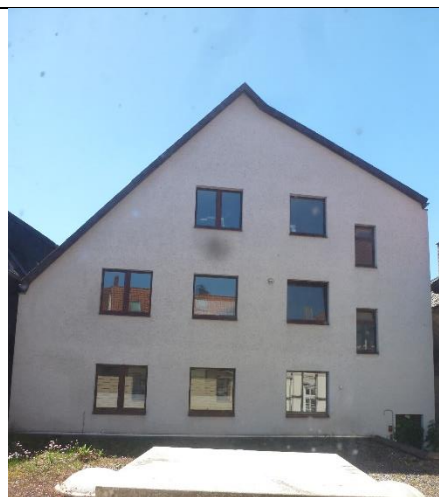
Ansicht von Norden (Vorderhaus)
