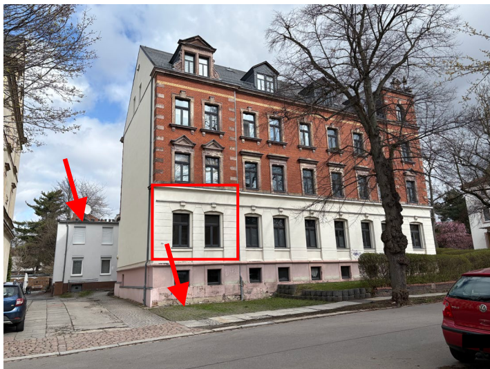
Abb. 02 Ansicht des Gebäudes von der Florastraße aus mit Grundstückszufahrt und Teilansicht Hintergebäude sowie Lage der Wohnung WE 1 im Erdgeschoss und Lage von Stellplatz Nr. 7, Südwesten
