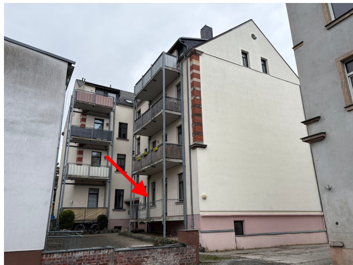
Abb. 04 Rückansicht des Gebäudes sowie Lage der Wohnung WE 1 im Erdgeschoss, Norden
