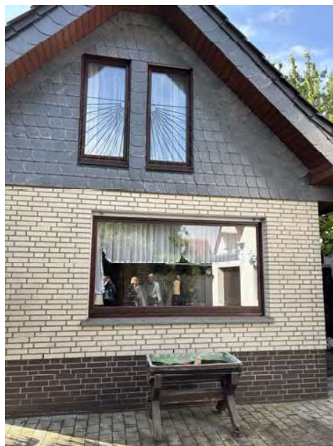
Ansicht Nord Anbau
