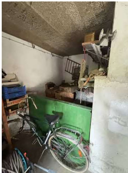
Nebengebäude ehemaliger Stall
