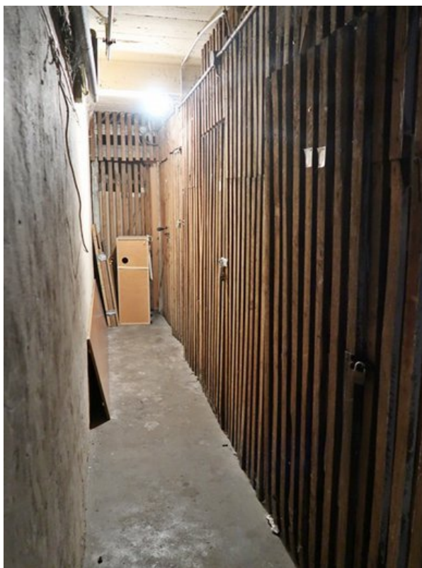
Kellergeschoss: Flur zu den Abstellkellern
