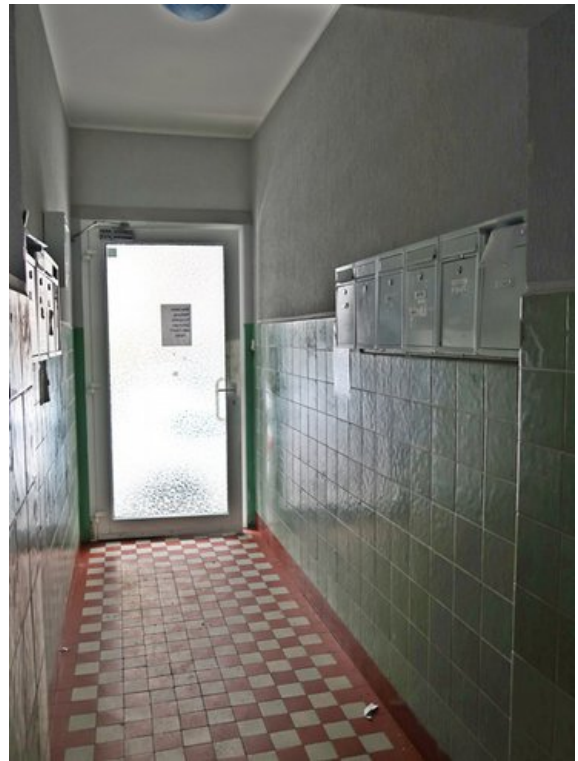
Treppenhaus mit Hauseingangstür
