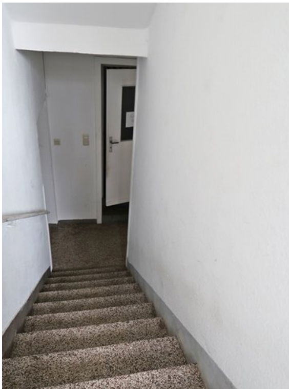
Treppe zum Kellergeschoss
