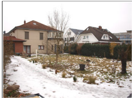
straßenseitige Ansicht aus Richtung Süden
