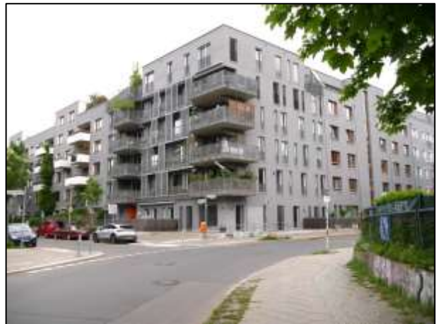
Gebäudekomplex - Brehme-/Heynstraße u.a.
