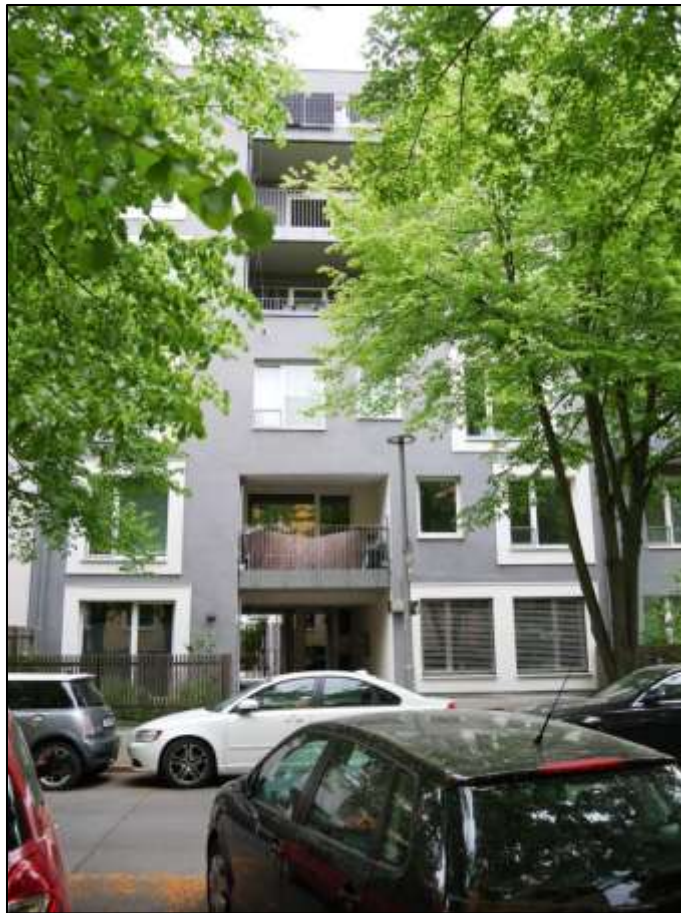
Blick über die Görschstraße nach Osten auf den Gebäude- teil Görschstr. 26B mit Gebäu- dedurchgang zum Blockin- nenbereich mit Bordschwellen- absenkung für den Müllgefäß- transfer
