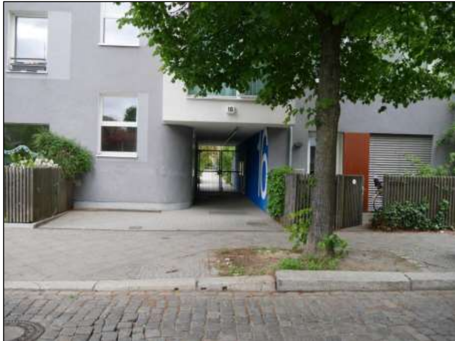
Blick aus der Heynstraße auf den Gebäudedurchgang zum Blockinnenbereich im Gebäudeteil Heynstraße 16
