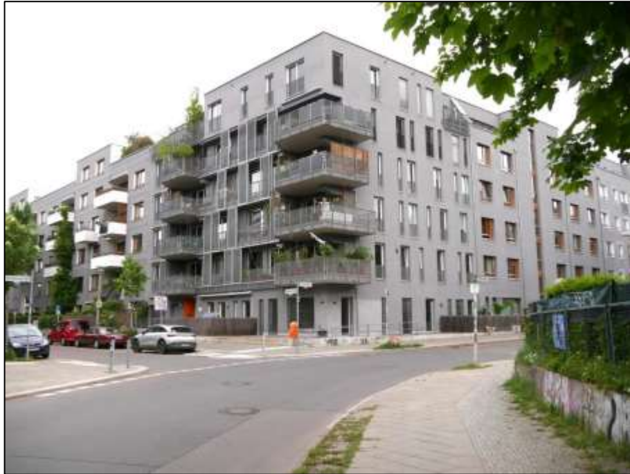
Grundstücksecke Heynstraße/Brehmestraße (links im Bild) mit aufstehendem Gebäudekomplex und KITA im Erdgeschoss der Gebäudeecke
