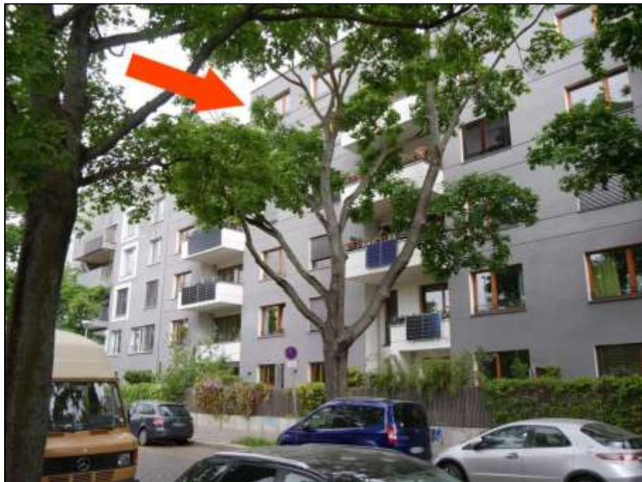
Blick über die Brehmstraße nach Nord-Westen auf den zur Brehmstraße orientierten Gebäudezug mit Lage des Wohnungseigentums Nr. 22 im Gebäudeteil Brehmestr. 37 im 4.OG/DG (Pfeil)
