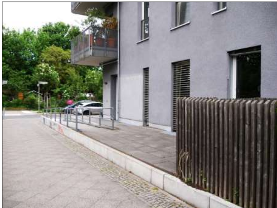
vor der Gebäudeecke zur Brehmestraße belegene Rampe an der Heynstraße zu der KITA im Erdgeschoss des Gebäudeecke
