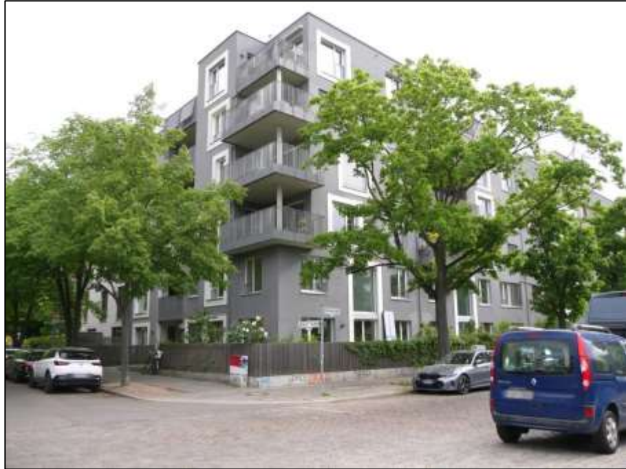
Grundstücksecke Görschstraße/Brehmestraße mit aufstehendem Gebäudekomplex
