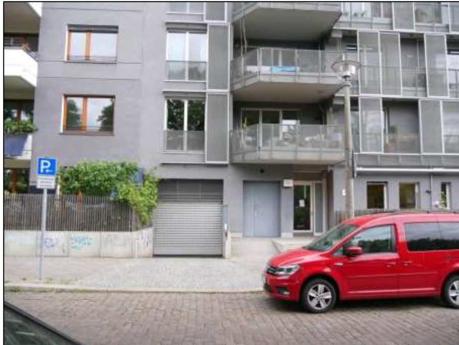
straßenseitige Front des Gebäudeteils Brehmestr. 35 im Bereich der Sockelzone mit angehobenem Vorgartenstreifen links und Hauseingang des Treppenhauses des Gebäudeteils Brehmestr. 35 rechts im Bild mit dazwischen belegener Tiefgaragen-Rampen-Ein- und Ausfahrt nebst lüftungsdurchlässigem Sektionaltor
