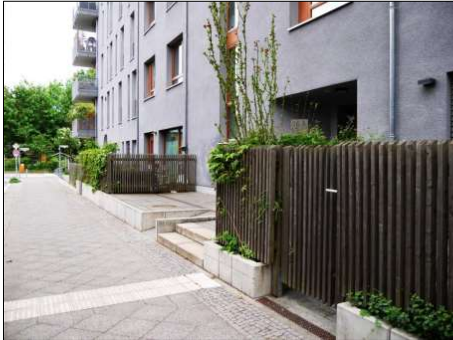
zur Heynstraße orientierte Front des Gebäudekomplexes mit partiell vorhandenen Vorgartenstreifen und Differenztreppen zum Treppenhauseingang Heynstr. 16A und zu den Gewerbeeinheiten u.a. auch mit davor belegenen Rampen
