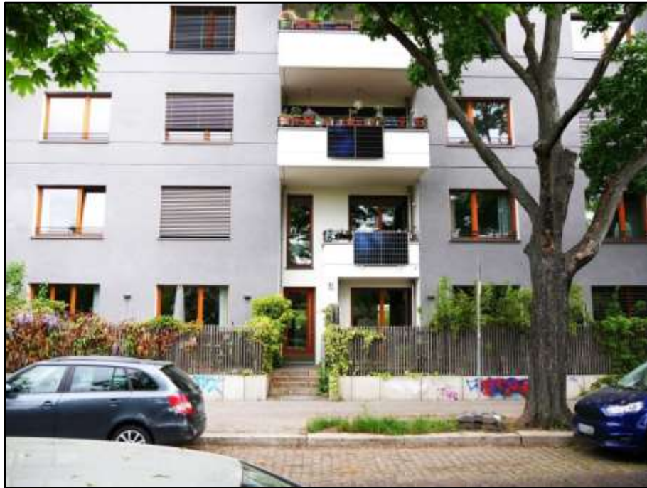
straßenseitige Front des Gebäudeteils Brehmestr. 37 im Bereich der Sockelzone mit angehobenem Vorgartenstreifen und Hauszuwegung zum Treppenhauseingang des Gebäudeteils Brehmestr. 37
