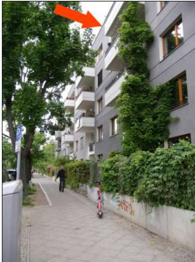
Blick über den Bürgersteig vor dem Gebäudeteil Brehmestr. 37 nach Westen mit zur Brehmestraße orientiertem Gebäudezug und Lage des Wohnungseigentums Nr. 22 im Gebäudeteil Brehmestr. 37 im 4.OG/DG (Pfeil)
