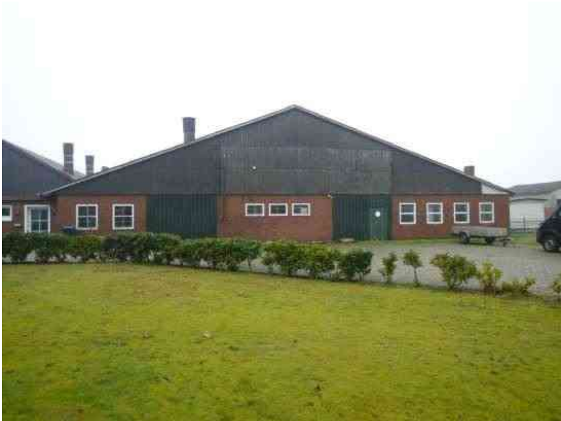
Frontansicht eh. Wirtschaftsgebäude / Schweinestall (stillgelegt) / Ansicht aus östlicher Richtung
