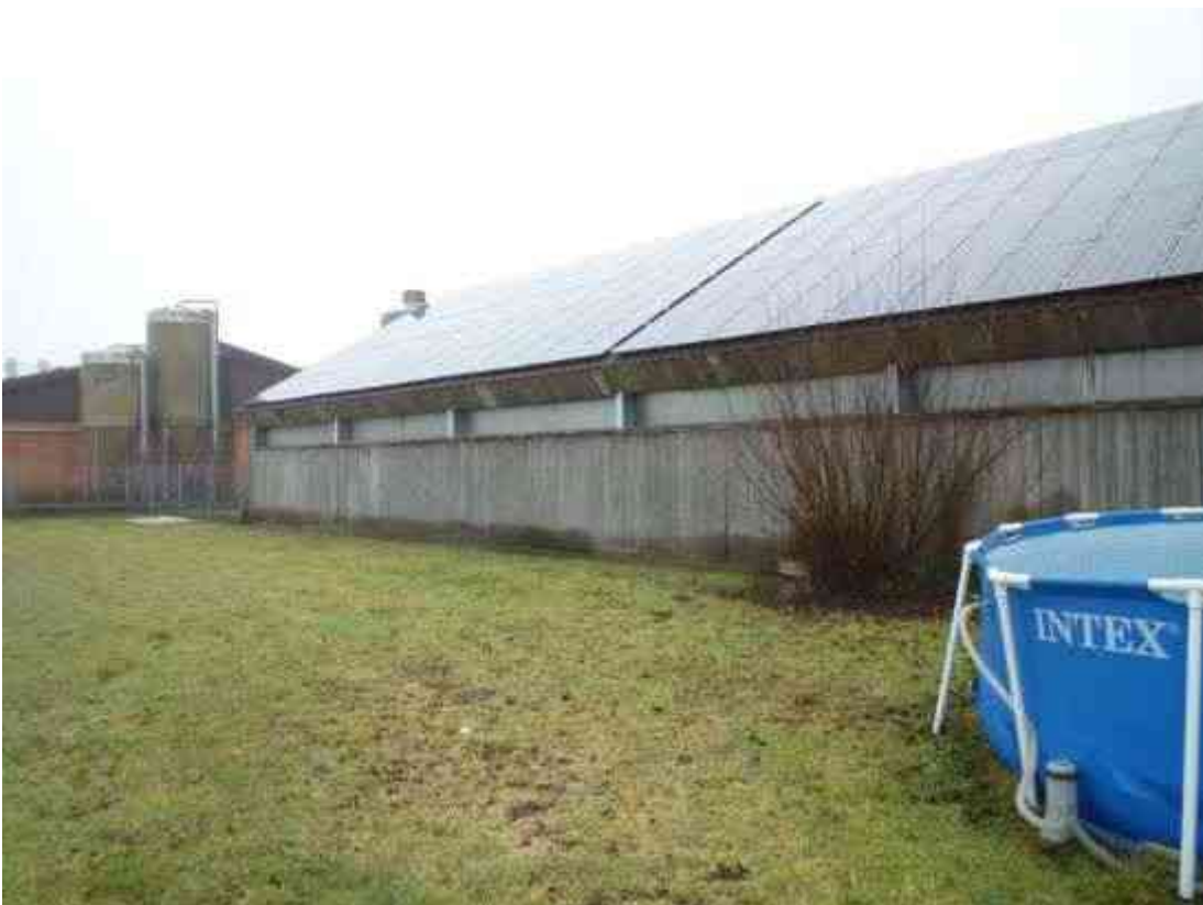
Seitenansicht eh. Boxenlaufstall / Schweinestall (stillgelegt) / Ansicht aus südlicher Richtung
