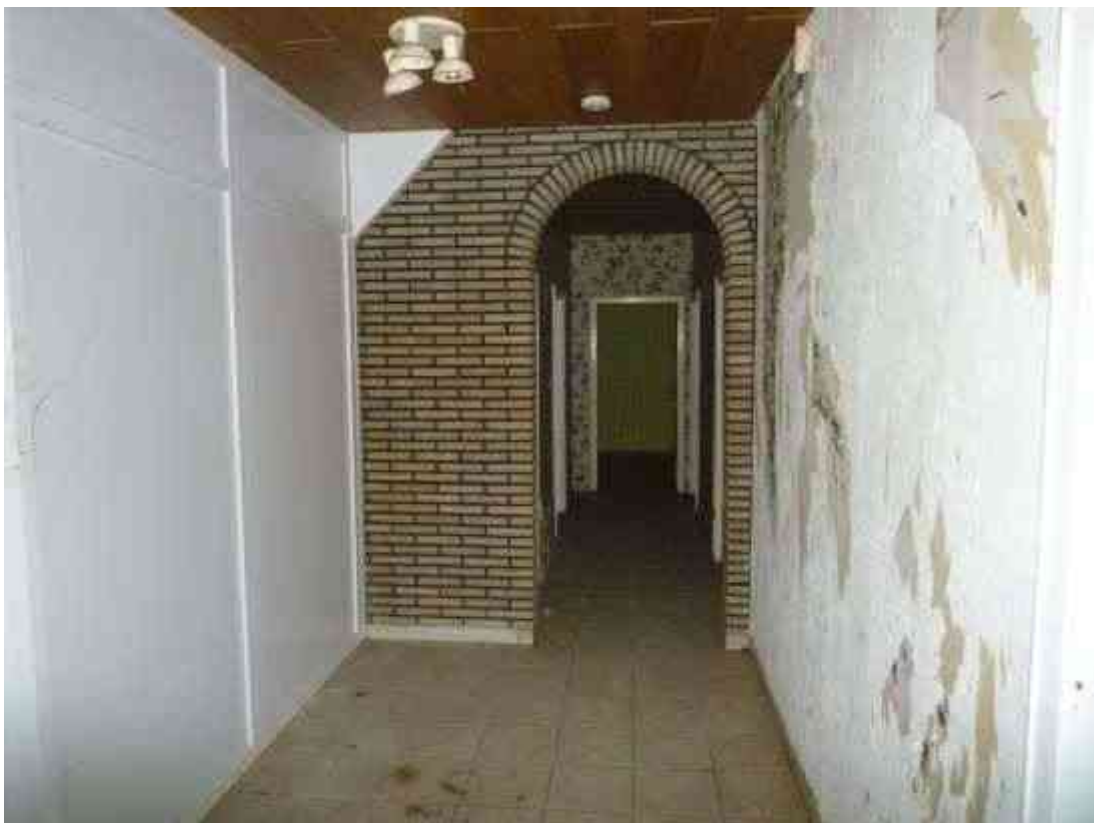
Flur Erdgeschoss / Wohnhaus
