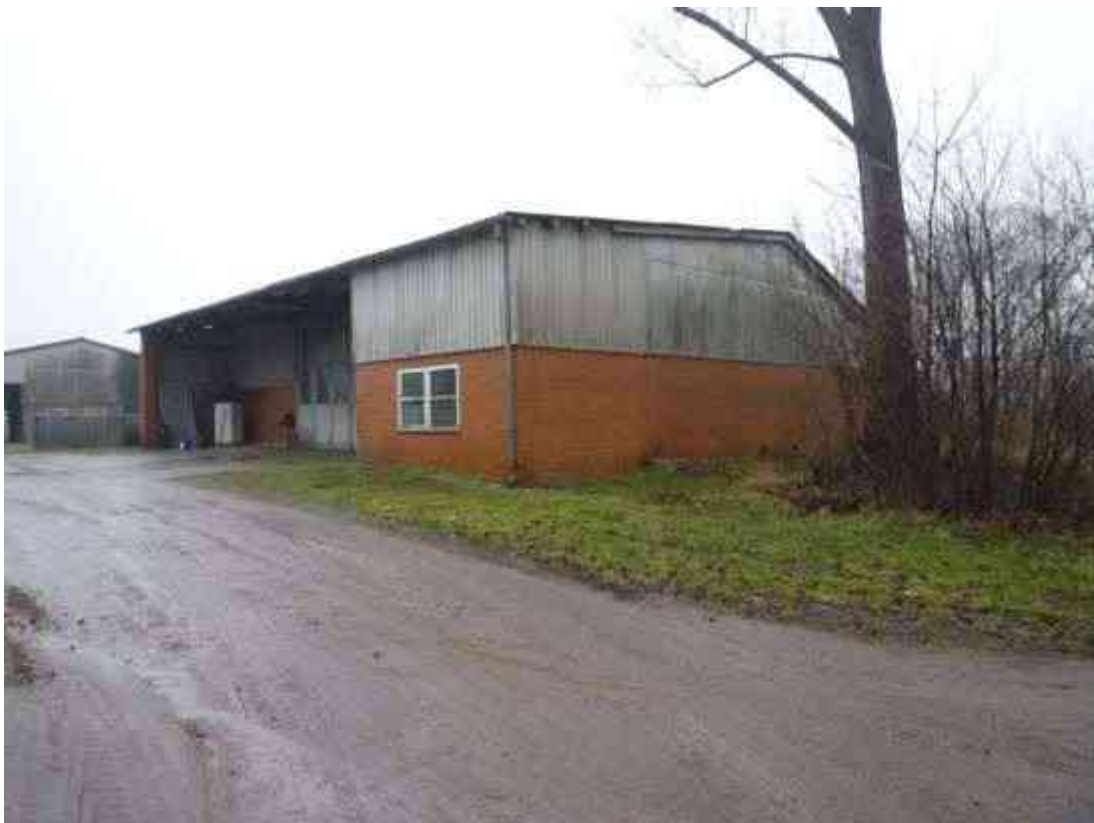
Seitenansicht Maschinen- und Gerätehalle (Baujahr 1978) / Ansicht aus südöstlicher Richtung
