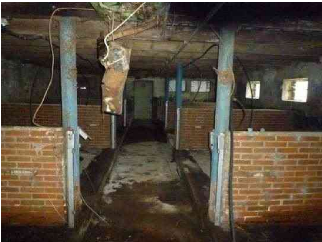
eh. Wirtschaftsgebäude / Schweinestall (stillgelegt) / Innenansicht
