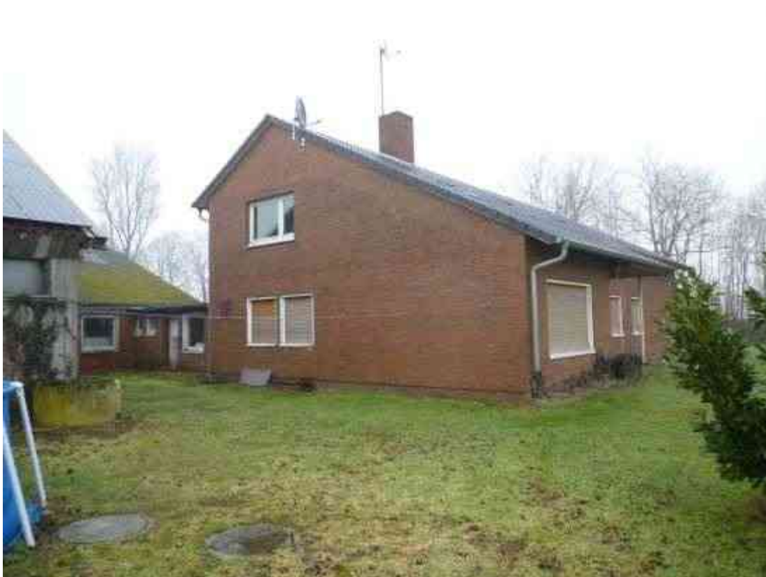
Rückansicht Wohnhaus / Ansicht aus westlicher Richtung
