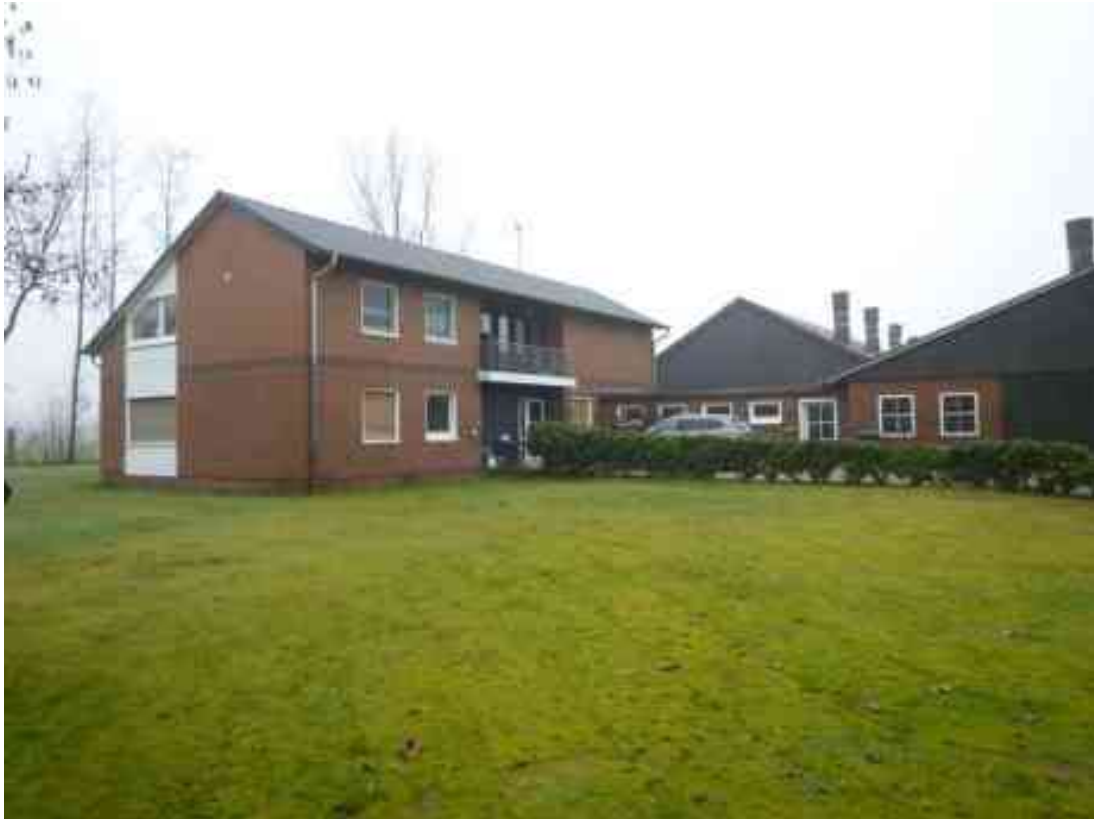
Frontansicht Wohnhaus nebst Anbau / Ansicht aus östlicher Richtung
