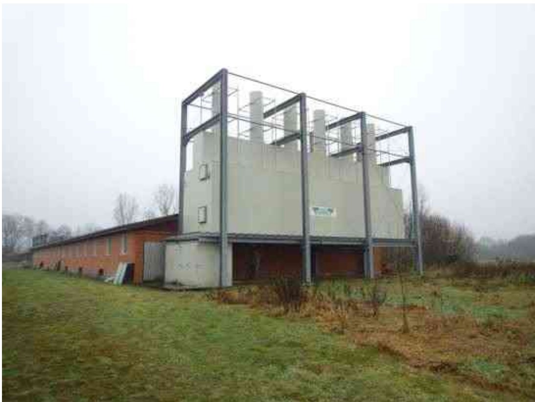
Rück- / Seitenansicht Schweinemaststall (Baujahr 2008) / Ansicht aus westlicher Richtung
