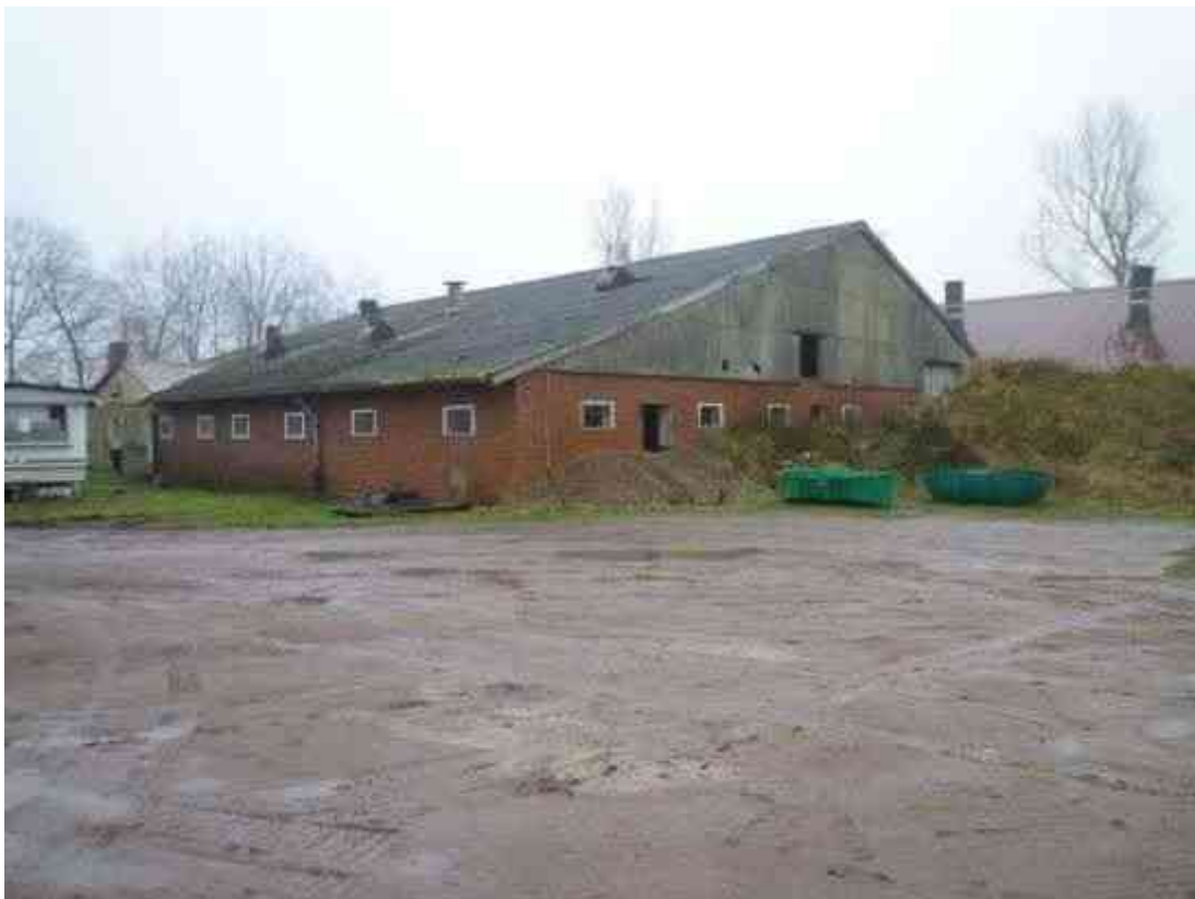
Rück- / Seitenansicht eh. Wirtschaftsgebäude / Schweinestall (stillgelegt) / Ansicht aus westlicher Richtung
