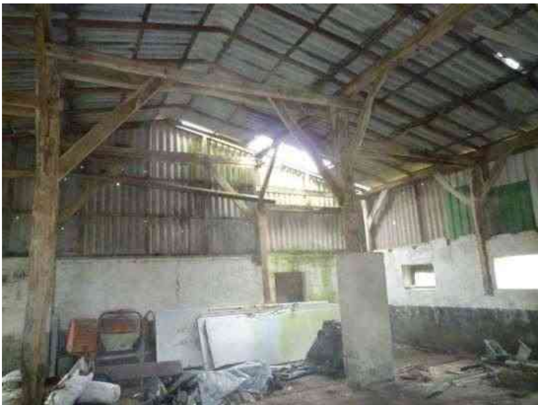
Scheune (Baujahr 1968) / Innenansicht
