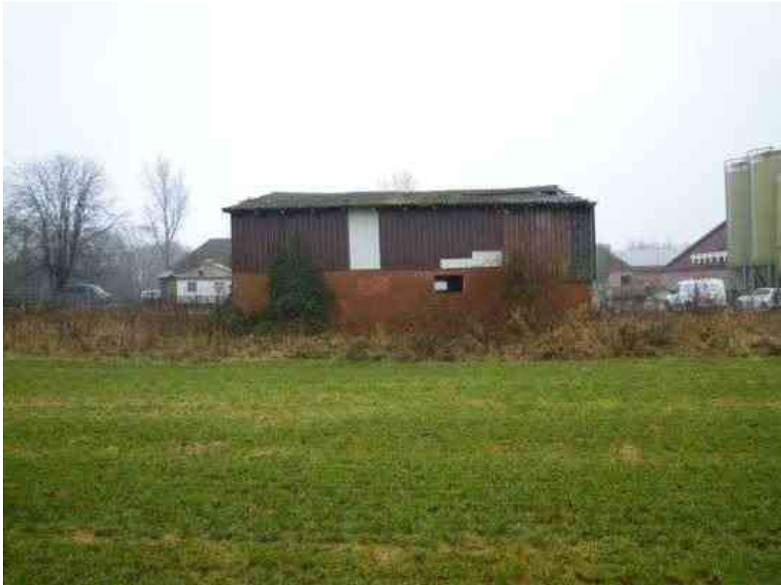
Rückansicht Scheune (Baujahr 1968) / Ansicht aus nördlicher Richtung
