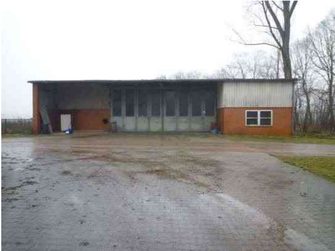
Frontansicht Maschinen- und Gerätehalle (Baujahr 1978) / Ansicht aus südlicher Richtung
