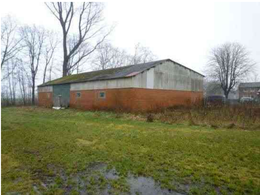
Rück- / Seitenansicht Maschinen- und Gerätehalle (Baujahr 1978) / Ansicht aus nordwestlicher Richtung
