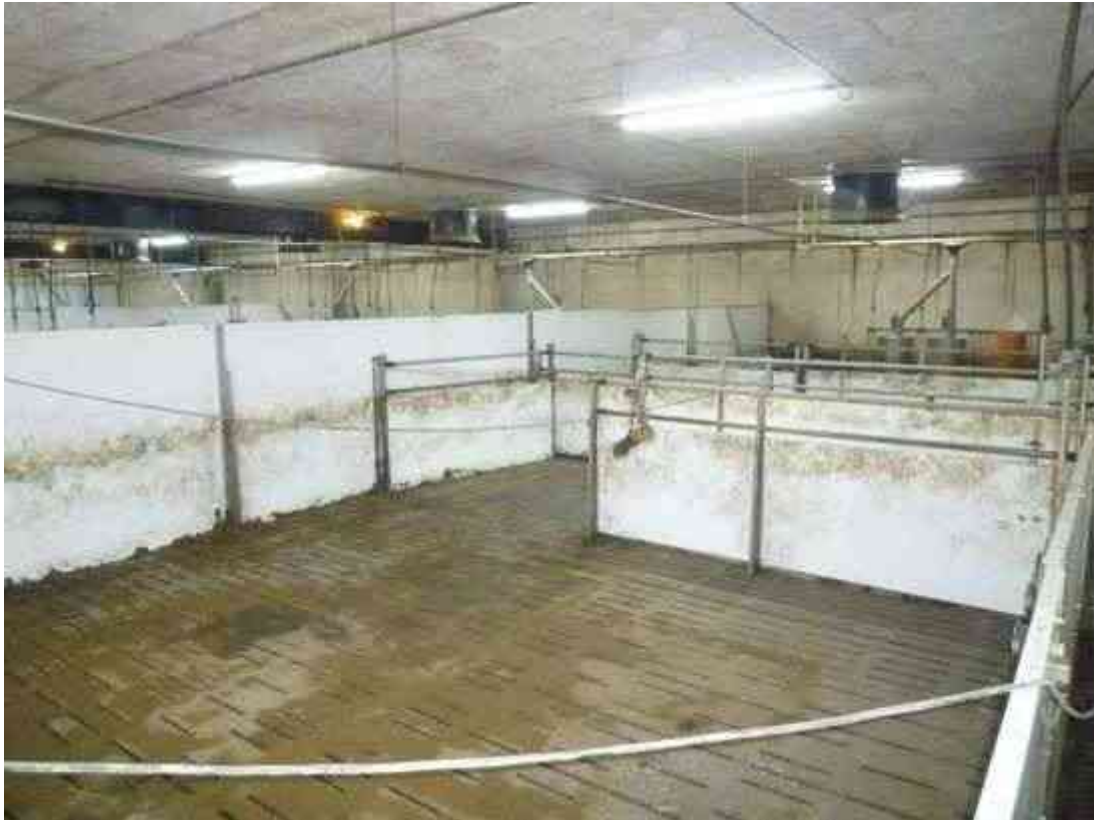
Schweinemaststall (Baujahr 2022) / Innenansicht
