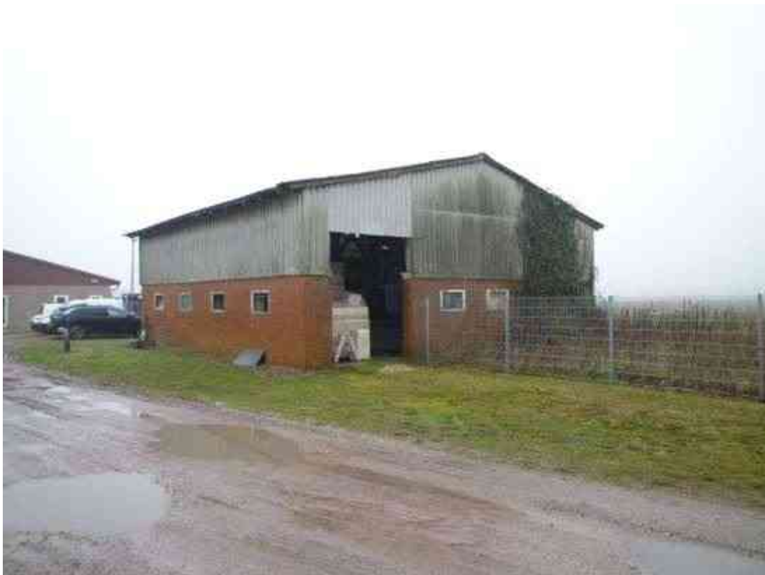
Front- / Seitenansicht Scheune (Baujahr 1968) / Ansicht aus südöstlicher Richtung
