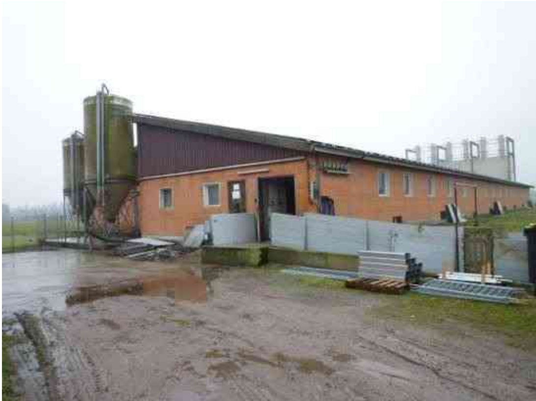
Front- / Seitenansicht Schweinemaststall (Baujahr 2008) / Ansicht aus nordöstlicher Richtung
