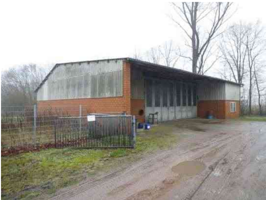
Seitenansicht Maschinen- und Gerätehalle (Baujahr 1978) / Ansicht aus südwestlicher Richtung
