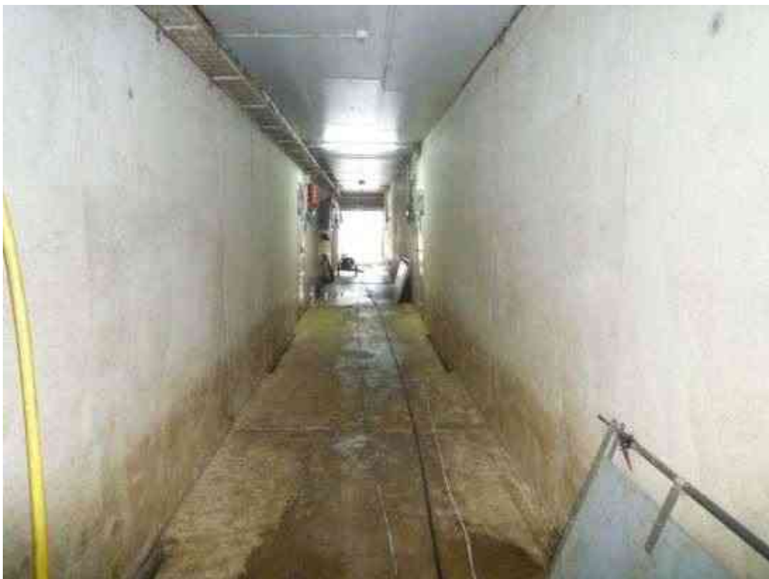
Schweinemaststall (Baujahr 2022) / Innenansicht
