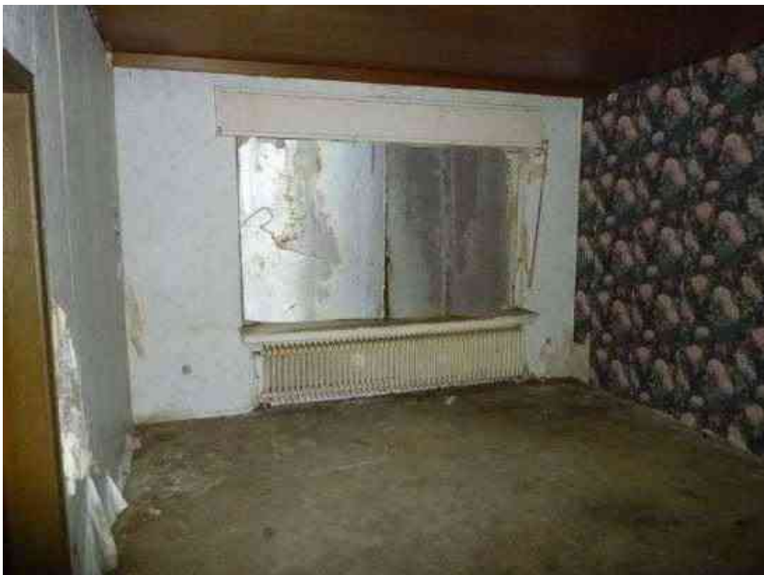
Esszimmer Erdgeschoss / Wohnhaus
