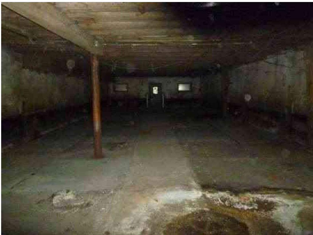
eh. Wirtschaftsgebäude / Schweinestall (stillgelegt) / Innenansicht
