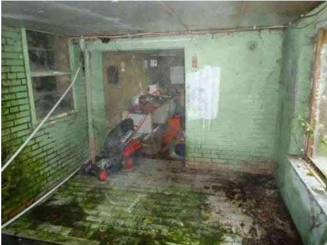
Nebenraum der Werkstatt / Anbau
