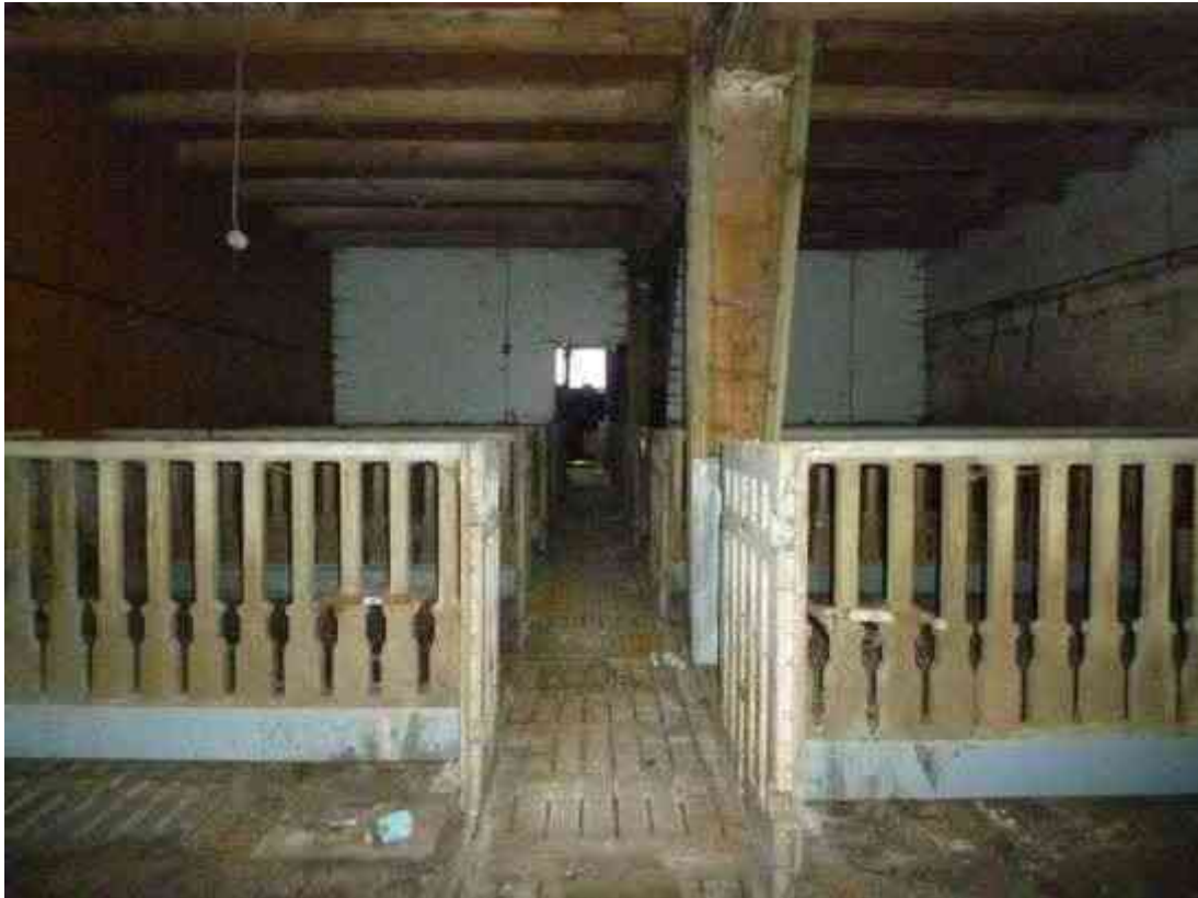
eh. Wirtschaftsgebäude / Schweinestall (stillgelegt) / Innenansicht
