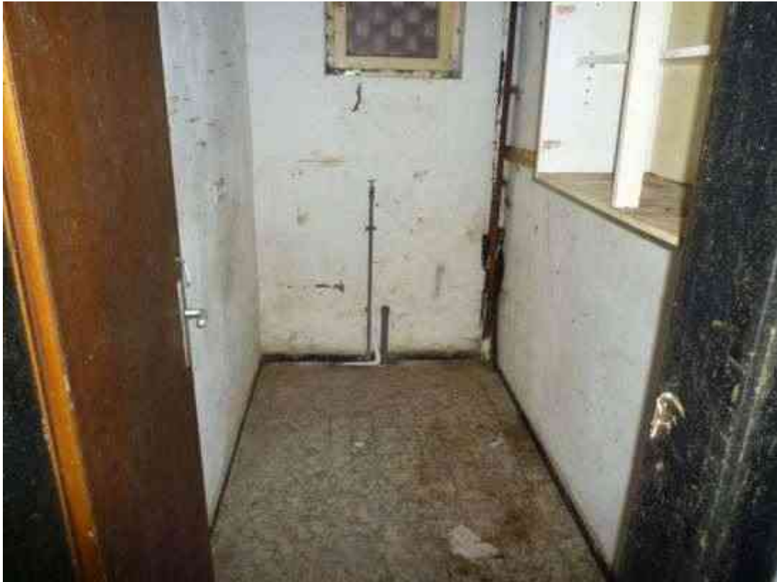
Abstellraum im Erdgeschoss / Wohnhaus
