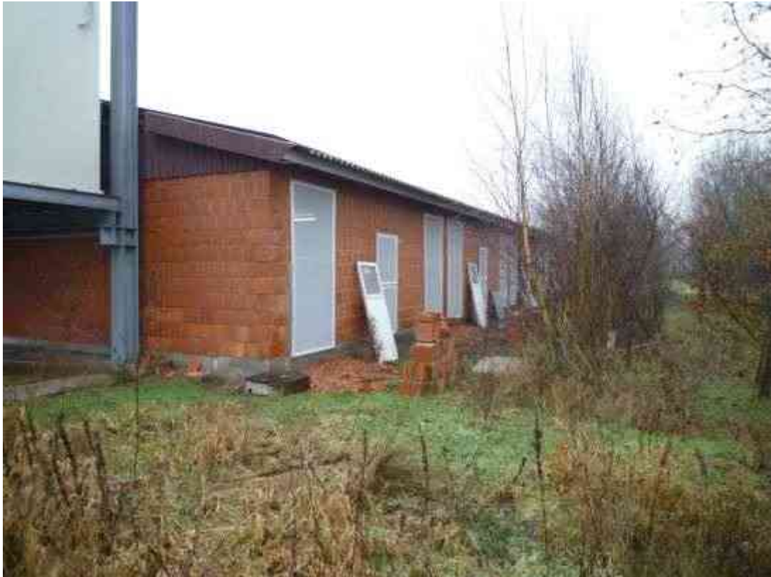
Seitenansicht Schweinemaststall (Baujahr 2008) / Ansicht aus südwestlicher Richtung
