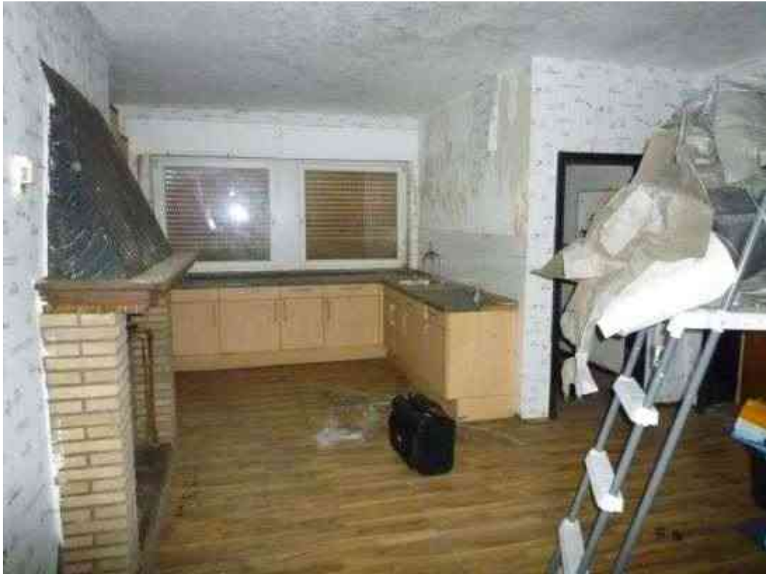
Küche Erdgeschoss / Wohnhaus
