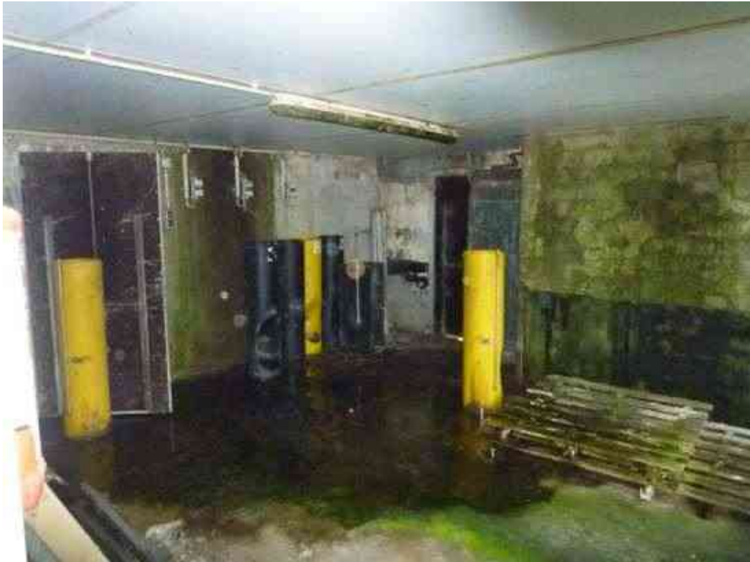
eh. Wirtschaftsgebäude / Schweinestall (stillgelegt) / Innenansicht
