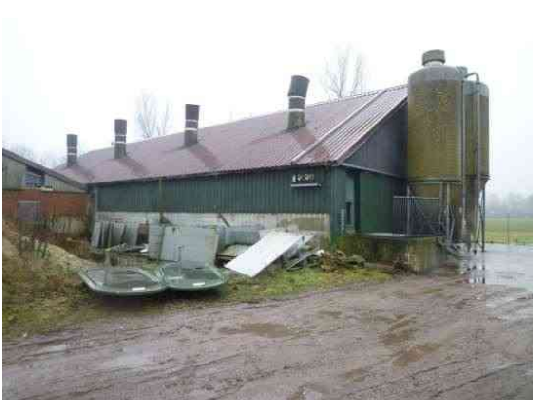
Front- / Seitenansicht eh. Boxenlaufstall / Schweinestall (stillgelegt) / Ansicht aus nordwestlicher Richtung
