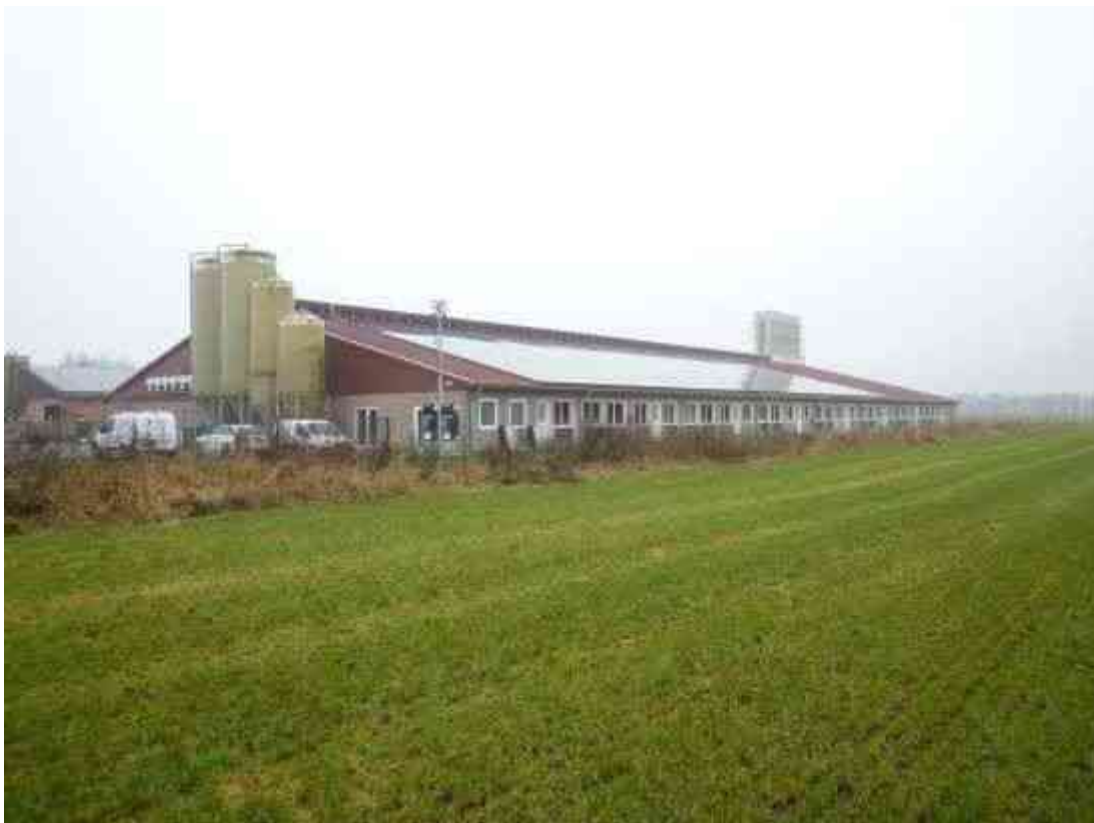
Front- / Seitenansicht Schweinemaststall (Baujahr 2022) / Ansicht aus nordöstlicher Richtung
