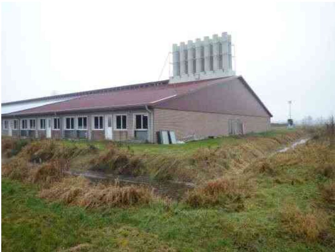
Rück- / Seitenansicht Schweinemaststall (Baujahr 2022) / Ansicht aus nordwestlicher Richtung
