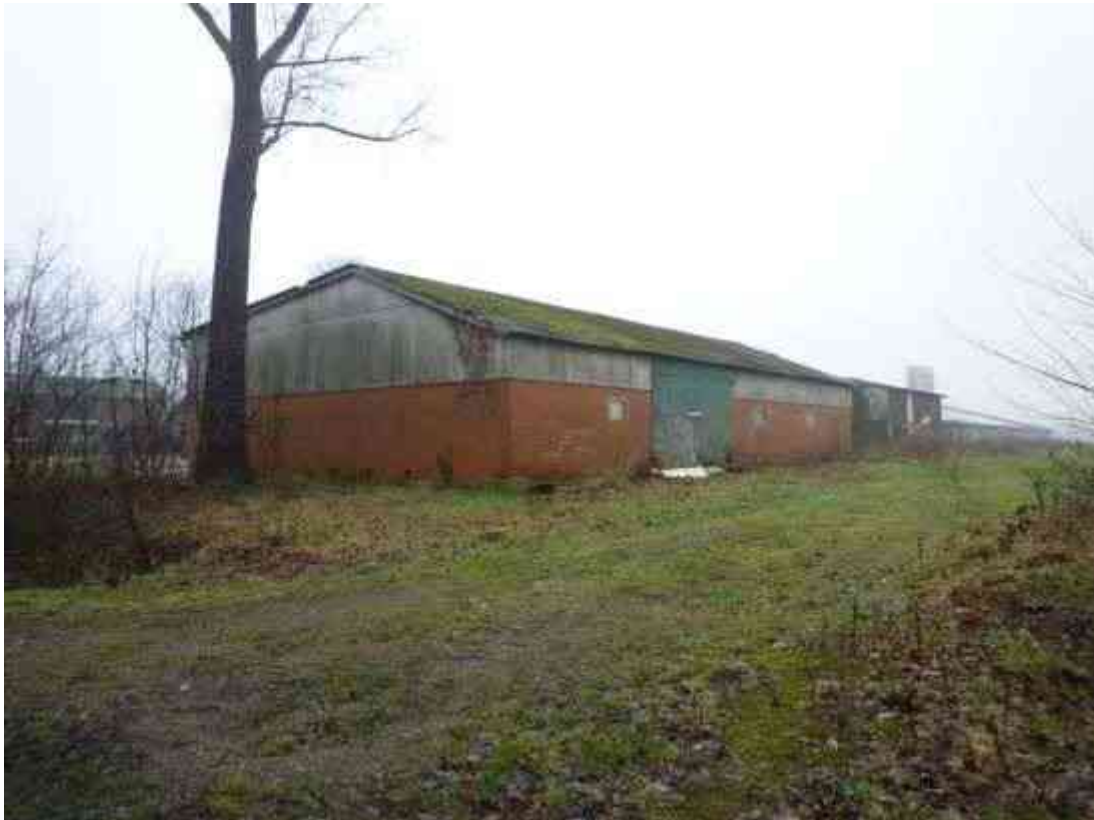
Rück- / Seitenansicht Maschinen- und Gerätehalle (Baujahr 1978) / Ansicht aus nordöstlicher Richtung
