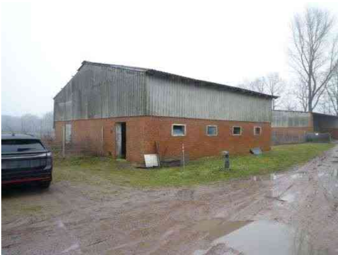
Front- / Seitenansicht Scheune (Baujahr 1968) / Ansicht aus südwestlicher Richtung
