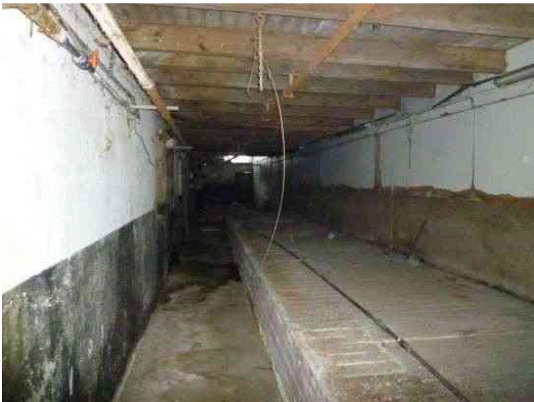
eh. Wirtschaftsgebäude / Schweinestall (stillgelegt) / Innenansicht
