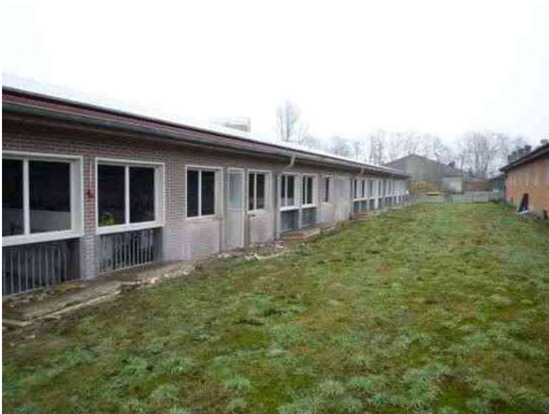
Seitenansicht Schweinemaststall (Baujahr 2022) / Ansicht aus westlicher Richtung
