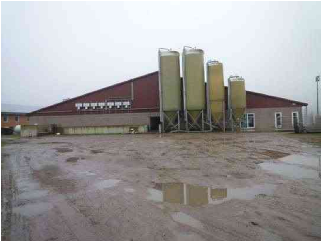
Frontansicht Schweinemaststall (Baujahr 2022) / Ansicht aus östlicher Richtung
