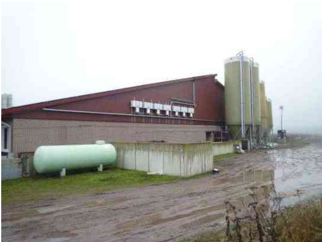
Frontansicht Schweinemaststall (Baujahr 2022) / Ansicht aus südöstlicher Richtung
