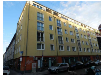
Ansicht von Süden von der Kreittmayrstraße
