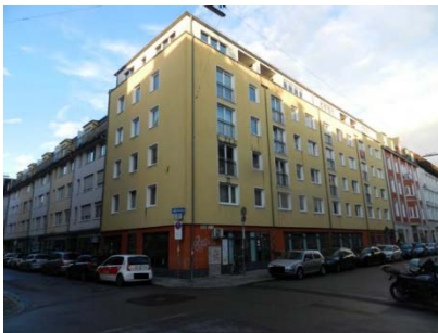
Ansicht von Südwest von der Kreuzung Erzgießereistraße/ Kreittmayrstraße
