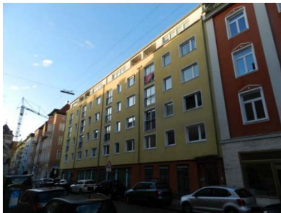
Ansicht von Süden von der Kreittmayrstraße
