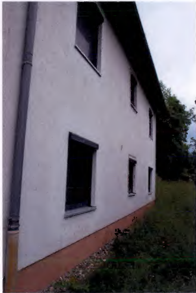
Nordseite des Wohnhauses
