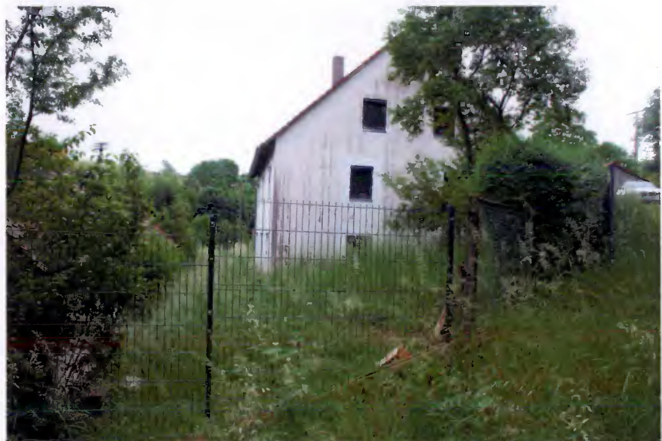
Westgiebel des Wohnhauses
