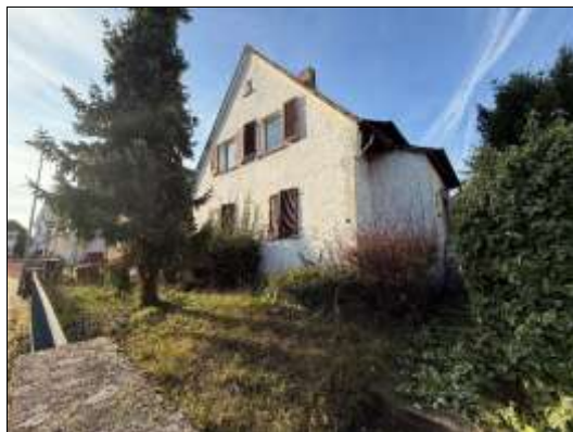
Ansicht von osten
