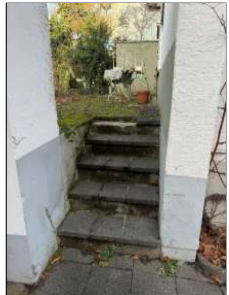
Treppe von der Garage zur Terrasse
